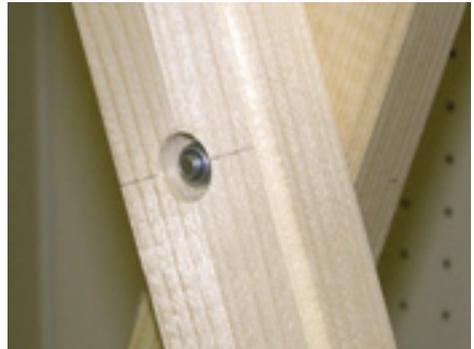
Komplizierter ist die Aussparung an den oberen Enden der HaXn damit man sie mit einem Strebenbrett im Modul verschrauben kann.
